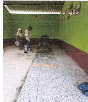
Foto 4: Colocación de piso de granito en la dirección del establecimiento como trabajo de mejoras
