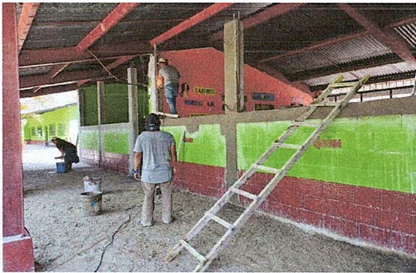
Foto 3: Repeyo de las columnas ya en ampliación donde van a colocarse las ventanas.
