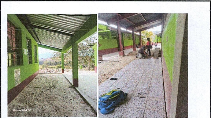
Foto 2: Colocación de piso de granito en los corredores de las aulas de preprimaria 1 y 2 y Segundo grado.
